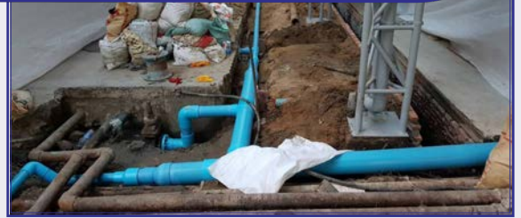
▶ เปลี่ยนท่อน้ำ PPR ใต้ดิน และ บนอาคารเซนต์พอลและอาคารโฮสปีตัล
