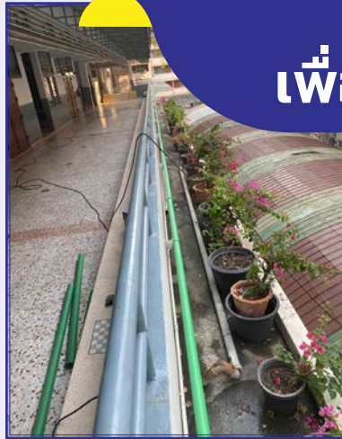
▶ เปลี่ยนท่อน้ำ PPR ใต้ดิน และ บนอาคารเซนต์พอลและอาคารโฮสปีตัล
