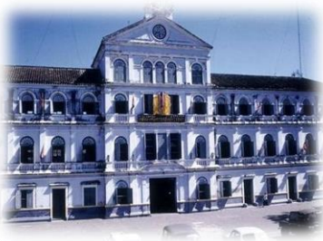
7. สถานีดับเพลิงบางรัก
