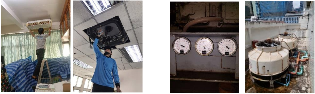
ล้างอัดฉีดเครื่องปรับอากาศและตรวจเช็ค cooling เครื่องปรับอากาศและระบบไฟฟ้าหอประชุมทรินิตี้
