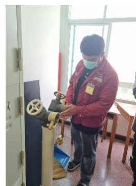
บำรุงรักษาเครื่องสูบน้ำและสายดับเพลิง
