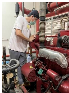
บำรุงรักษาเครื่องสูบน้ำและสายดับเพลิง
