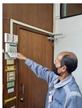
ตรวจเช็คระบบแจ้งภัยฉุกเฉิน
