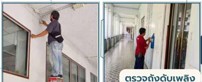
การไฟฟ้านครหลวงตรวจสอบระบบไฟฟ้า
